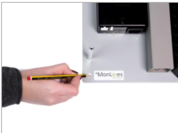
Abb. 5: Bohrlöcher anzeichnen und bohren
